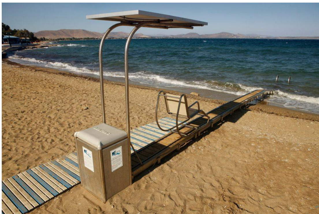
Εικόνα 14 Ενδεικτική φωτογραφία διάταξης πρόσβασης των ΑμΕΑ στο θαλάσσιο χώρο
