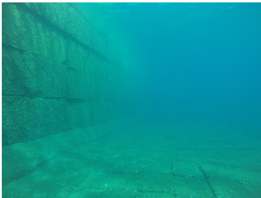
Εικόνα 3-9: Άποψη υφιστάμενης κατάστασης ανατολικού κρηπίδωματος (τμήμα Β-Γ)
