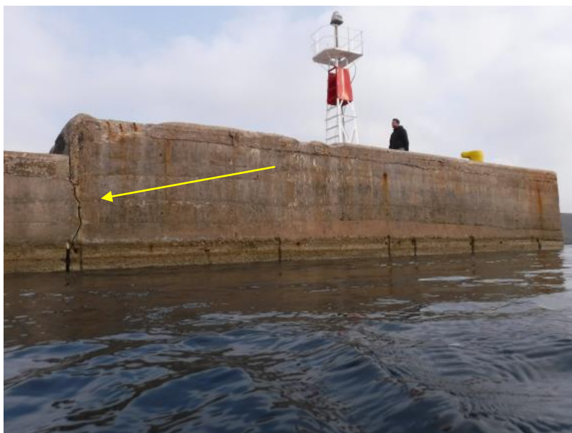
Εικόνα 3-16: Κατακόρυφη ρηγμάτωση στο μέτωπο της ανωδομής στο ανατολικό όριο της ράμπας
