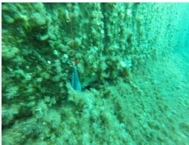
Εικόνα 3-4: Έλεγχος κατακορύφωσης κρηπιδοτοίχου με την βοήθεια σκαντάγιου
