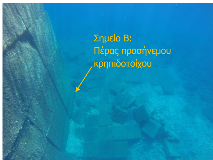
Εικόνα 3-6: Άποψη υφιστάμενης κατάστασης στο πέρας του προσήνεμου κρηπιδοτοίχου (Σημείο Β)
