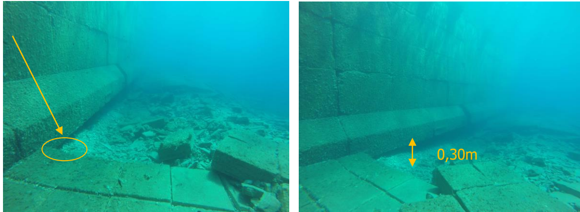
Εικόνα 3-2: Θέση έναρξης υποσκαφής
