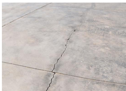
Εικόνα 3-14: Ρηγματώσεις στις χερσαίες επιστρώσεις
