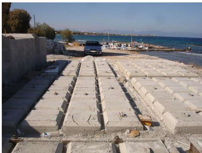
Εικόνα 3-19: Κλίση σκυροδέτησης στρωμάτων κυβολίθων
