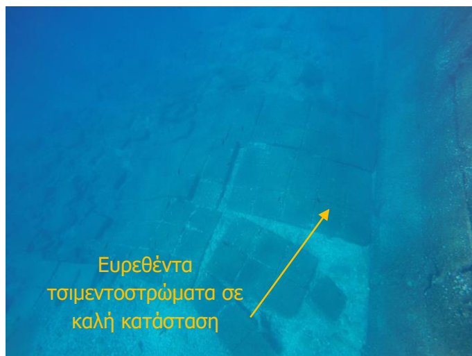
Εικόνα 3-5: Άποψη υφιστάμενης κατάστασης συστήματος προστασίας ποδός
