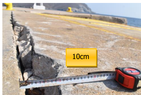
Εικόνα 3-17: Διευρυμένος αρμός στη διεπιφάνεια ράμπας και χερσαίων επιστρώσεων
