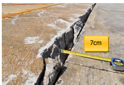
Εικόνα 3-16: Κατακόρυφη ρηγμάτωση στο μέτωπο της ανωδομής στο ανατολικό όριο της ράμπας
