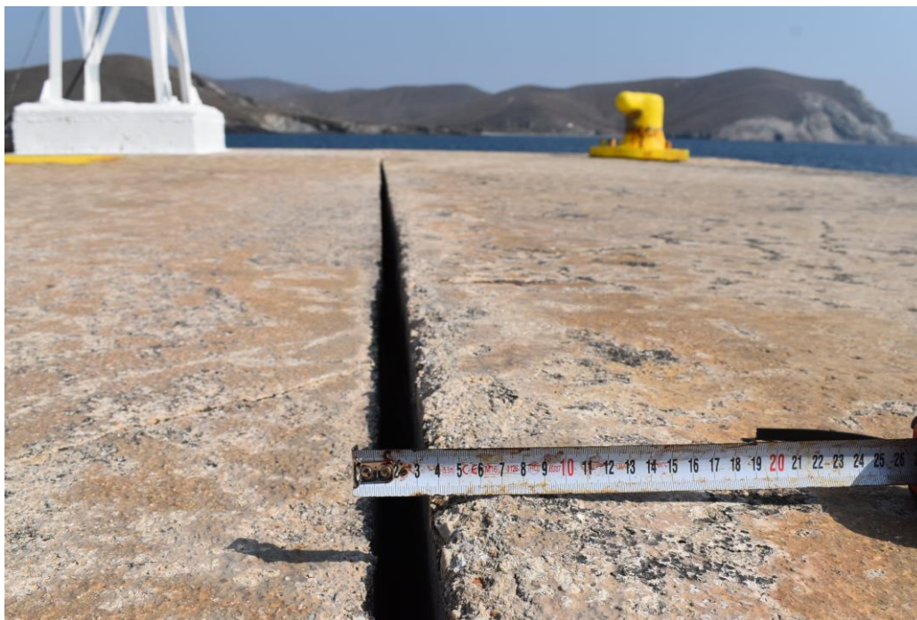
Εικόνα 3-13: Διευρυμένος αρμός στις χερσαίες επιστρώσεις
