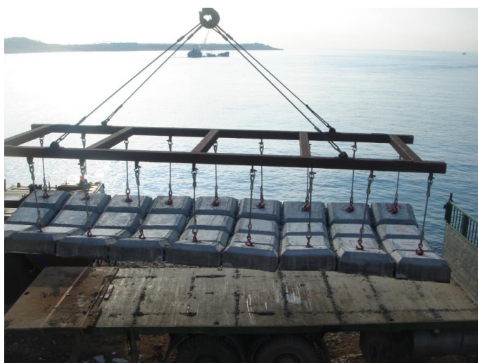
Εικόνα 3-20: Σύστημα ανάρτησης κυβολίθων
