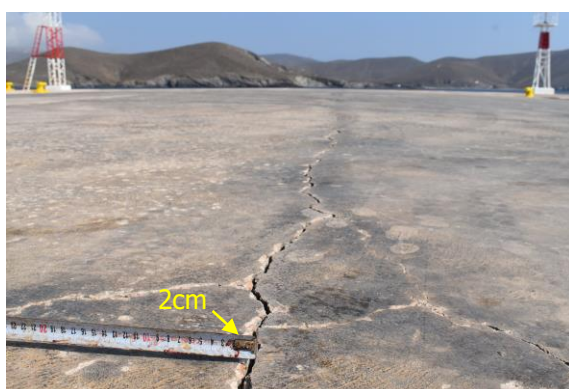
Εικόνα 3-14: Ρηγματώσεις στις χερσαίες επιστρώσεις
