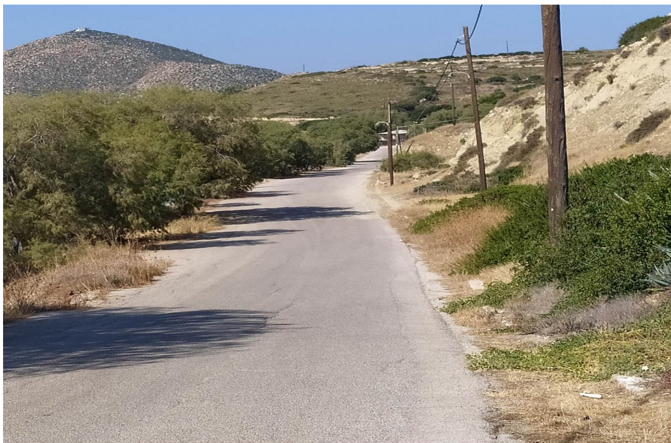
Εικόνα 13 Φωτογραφία θέσης ανακατασκευής οδοστρώματος.
