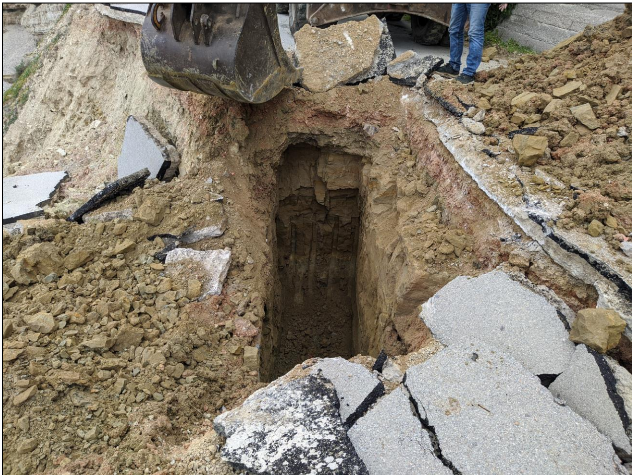
Εικόνα 7 Πραγματοποίηση δοκιμαστικής τομής με υδραυλικό εκσκαφέα.
