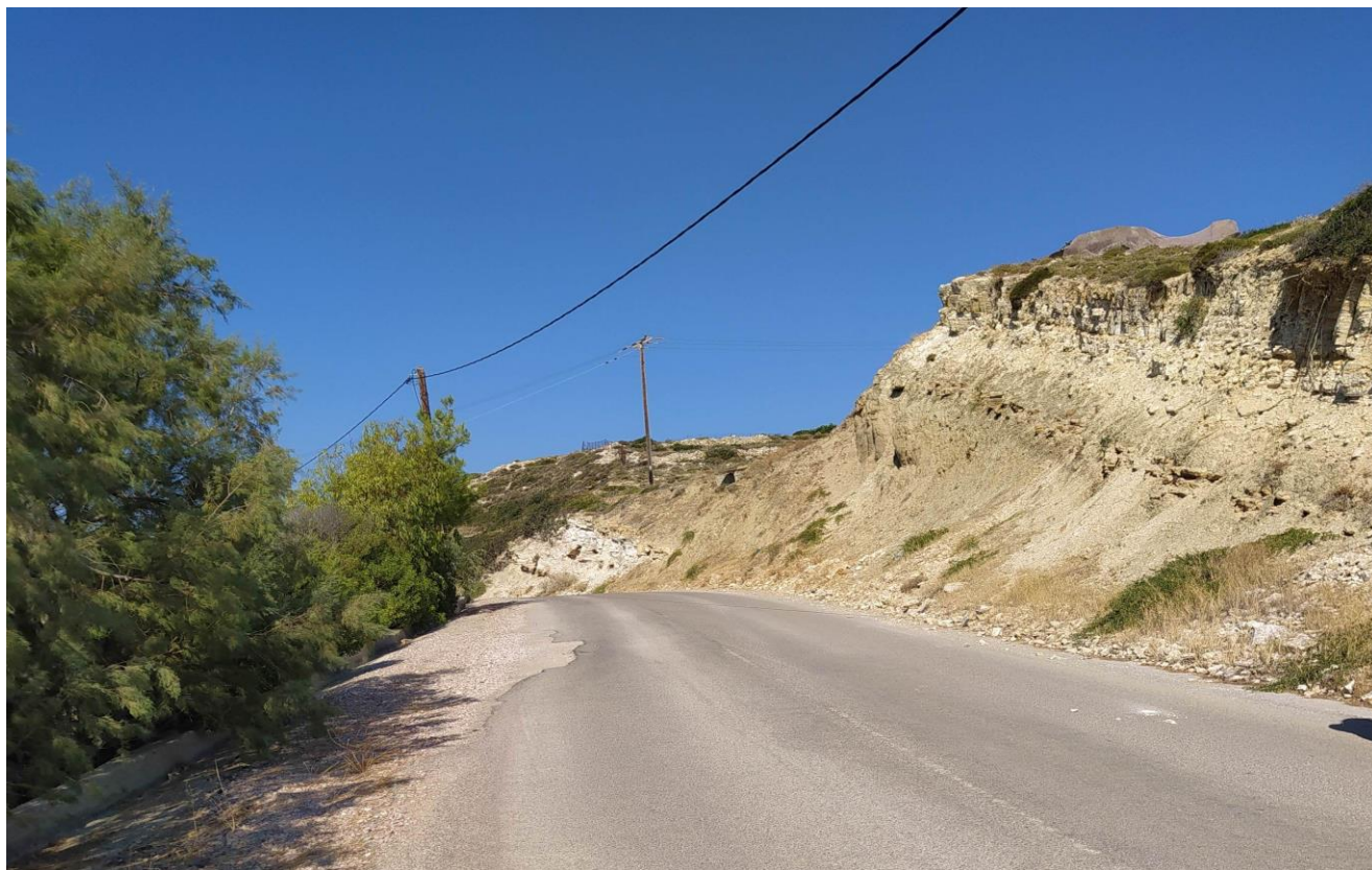
Εικόνα 11 Φωτογραφία θέσης τοποθέτησης συρματοκιβωτίων και ανακατασκευής κρασπέδου.
