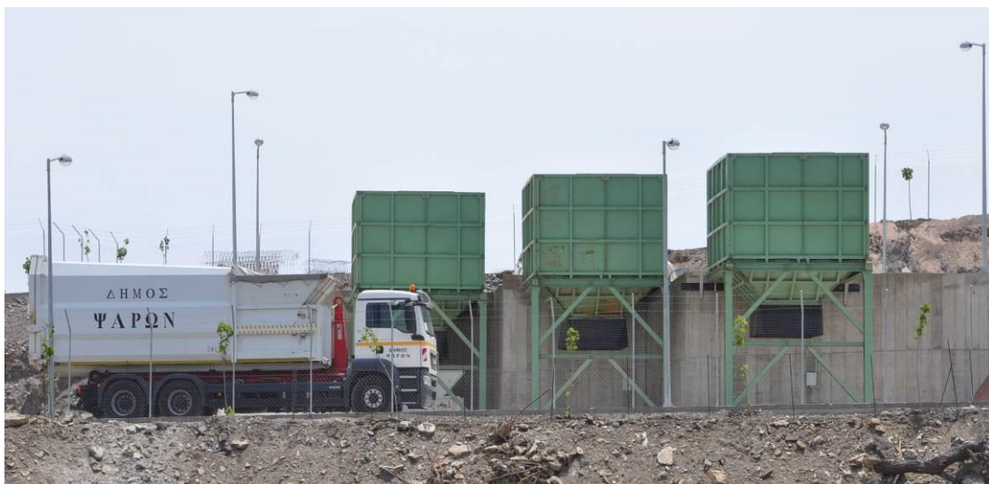
Εικ. 2.1: Άποψη των 3 χοανών ΣΜΑ (κάτω επίπεδο) & μεταφορά container από Ο.Μ. Hook lift
