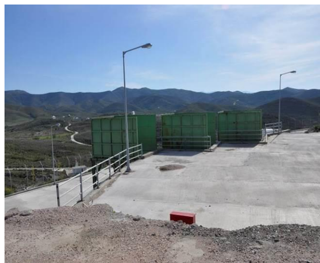
Εικ. 2.3: Διάταξη των 3 χοανών στις εγκαταστάσεις του ΣΜΑ (επίπεδο επίπεδο)
