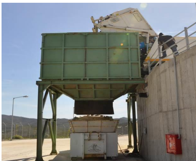
Εικ. 2.2: Διαδικασία πλήρωσης press container μέσω μεταλλικής χοάνης
