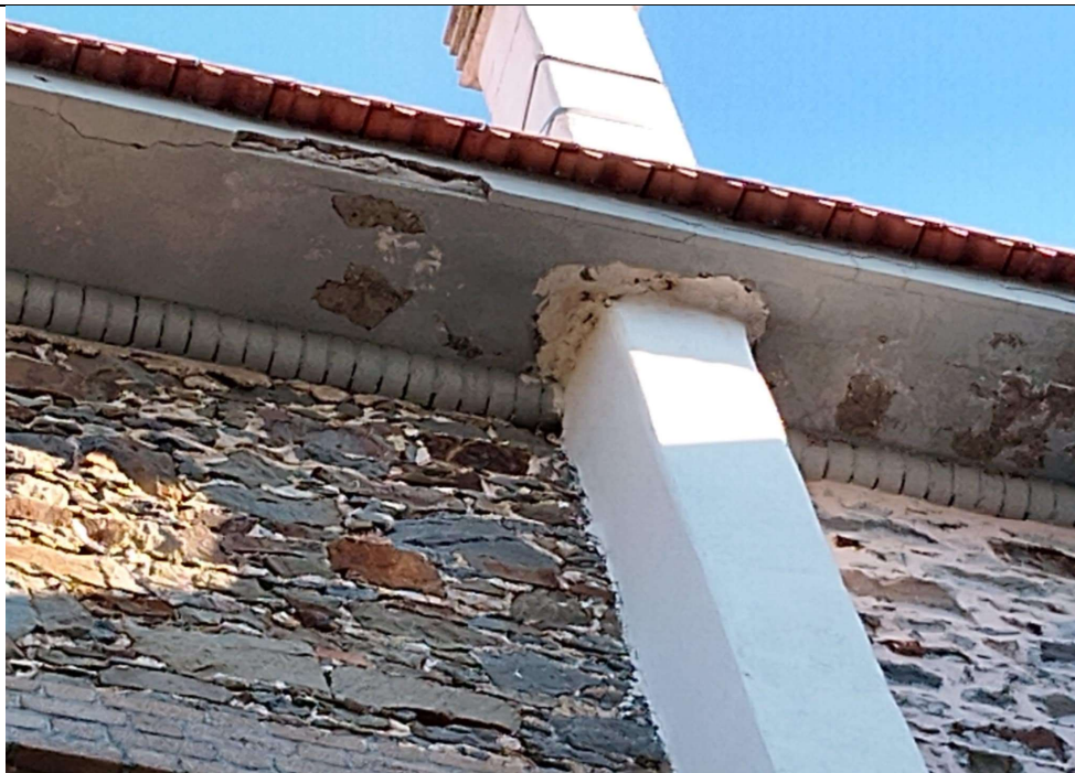
Επισκευή δυτικής κορνίζας κτιρίου
